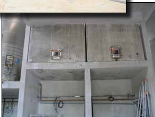
Une cave toute neuve et des cuves en béton non revêtu (Le Galoupet, photos ALPHA)
