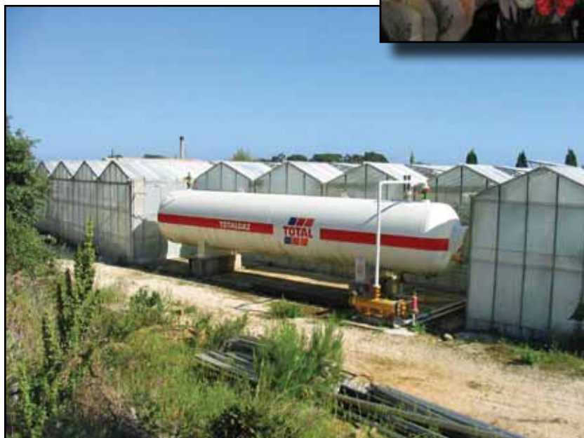
Chauffage des serres
